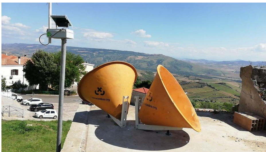
Figura 21 – Nodo sensore 49001 montato sulla struttura Murales, accanto ai riflettori radar
